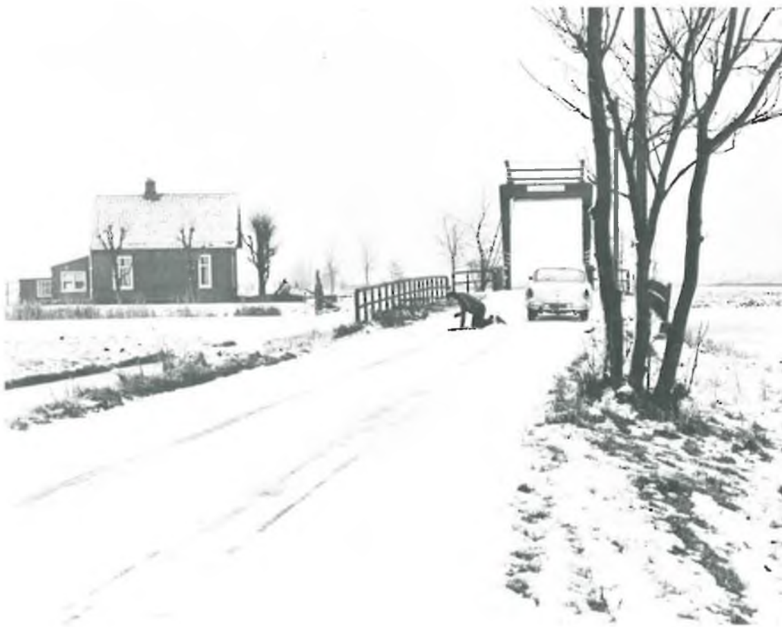
Karakteristiek zijn in Oostzaan nog altijd de ophaalbruggetjes.
